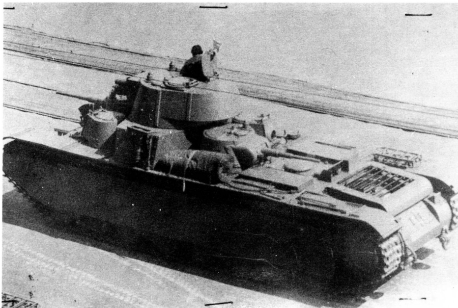
Т-35 с коническими башнями и наклонной подбашенной коробкой. Москва, 7 ноября 1939 года.
